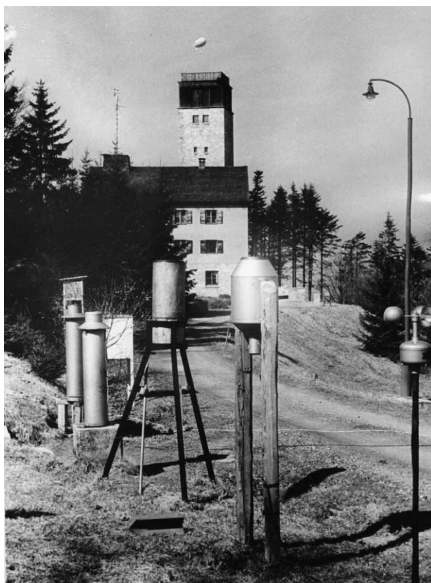
Bild 3: Teilansicht des Meßfeldes, im Hintergrund das Observatoriumsgebäude, über dem Turm ein Fesselballon. Aufnahme aus dem Jahre 1957.
